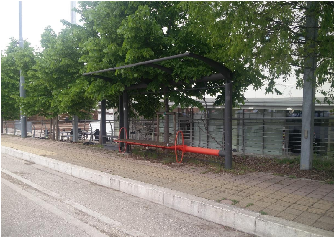
FOTO 15 † Strutture realizzate a supporto della tranvia su gomma (opera interrotta)
