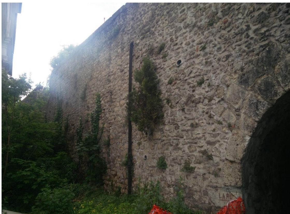
FOTO 10 † Muratura sostegno di Via Roma da Chiesa di Santa Croce
