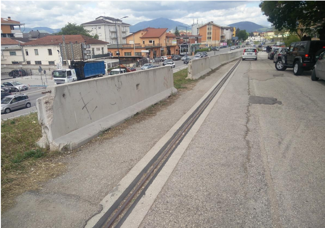
FOTO 17 - Strutture realizzate a supporto della tranvia su gomma (opera interrotta)
