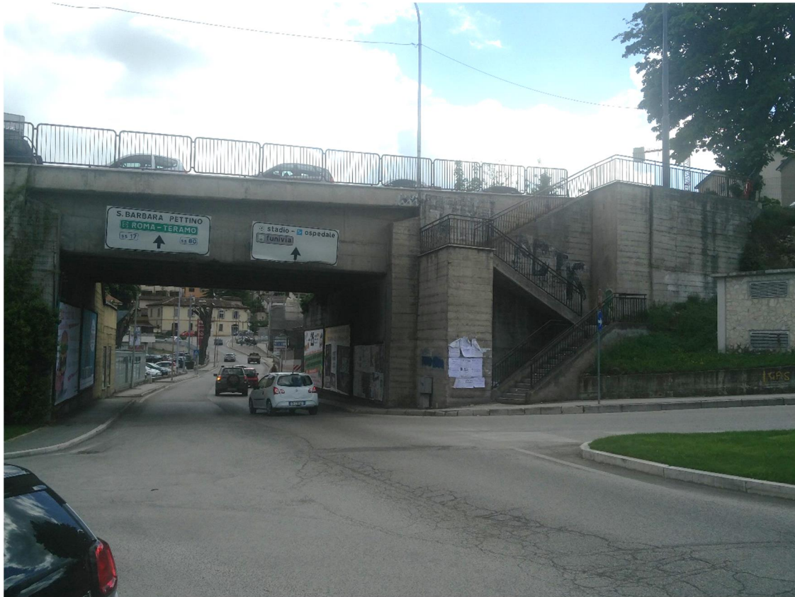
FOTO 5 † Cavalcavia Via Vicentini con annessa struttura di collegamento verticale
